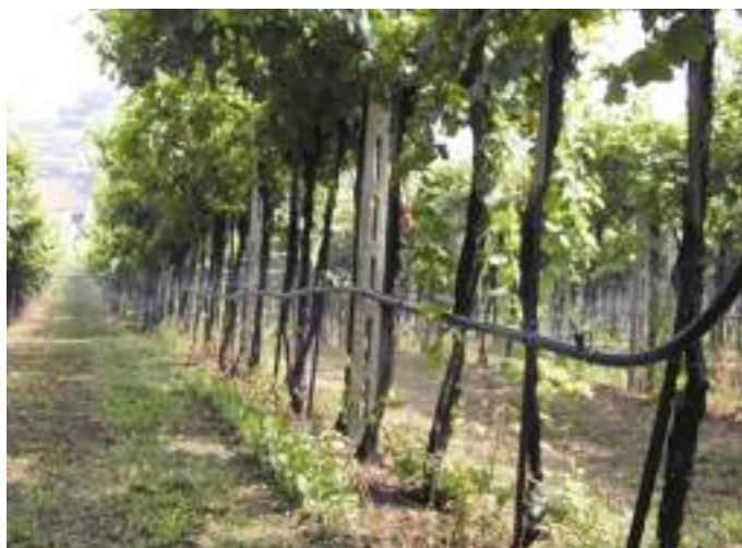
>> 4 / I movimenti della tubazione possono portare a mancanza di verticalità degli spruzzatori inseriti direttamente sulla tubazione.
