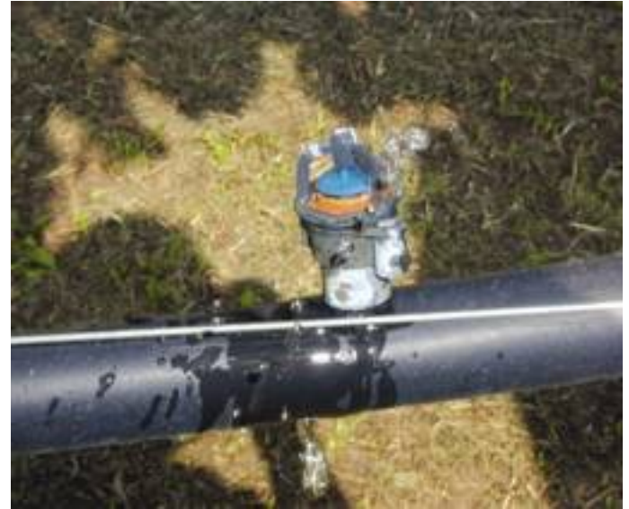
>> 5 / Microspruzzatore occluso per scarsa manutenzione.
