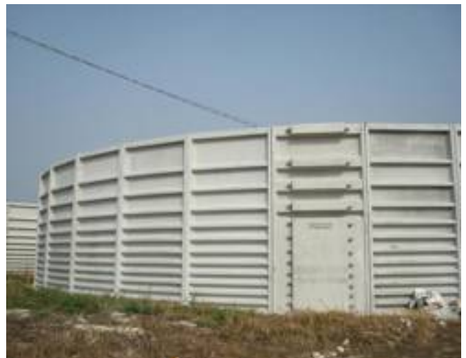
● Nell'immagine vediamo una vasca realizzata con moduli prefabbricati di 6 m di altezza. Sono ben visibili le nervature all'interno delle quali scorrono i cavi per la solidarizzazione.
