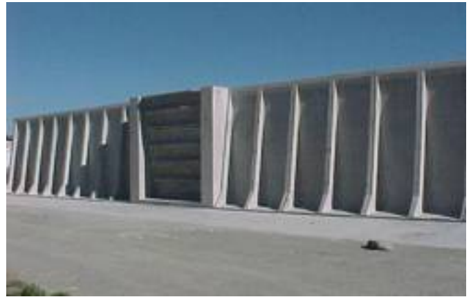
● L'elemento speciale, la cosiddetta «testata di tiro», consente la postcompressione dei moduli prefabbricati e la loro solidarizzazione.
