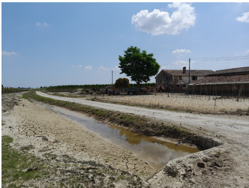
Area alluvionata. I canali sono colmi di depositi.
