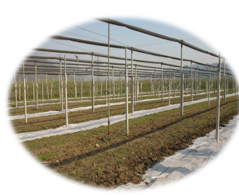
stanchezza de terreno
